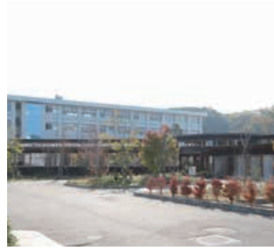
大崎海星高校の外観。地域に開かれた学校で、学内にも地域の人が頻繁に出入りする。赴任したての先生は学校内を知らない人が歩く状況に最初は驚くほどだそう。
